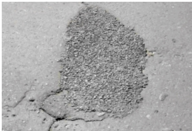
>>> Вид поверхности покрытия с МАК-смесью, уложенной при ямочном ремонте без разделки карт
