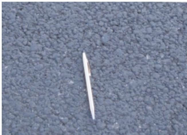
>>> Вид поверхности покрытия из горячей МАК-смеси на автостраде 1-70, штат Индиана, США
