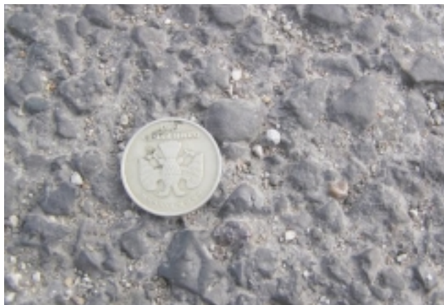
>>> Вид поверхности покрытия из горячей ЩМА-МАК-смеси после 12 лет эксплуатации
