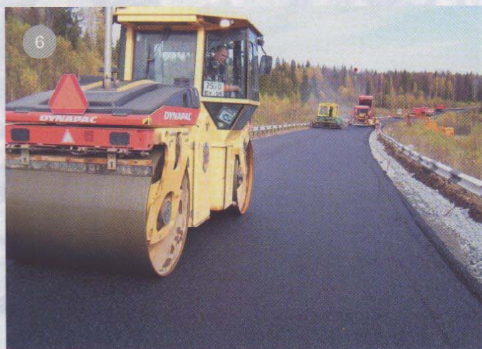
&gt;&gt;&gt; Укладка среднего дренирующего слоя из МАК-смеси
