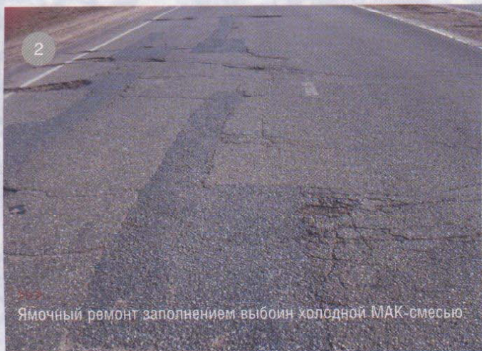
Участок ямочного ремонта холодной МАК-смесью после 3 лет эксплуатации
