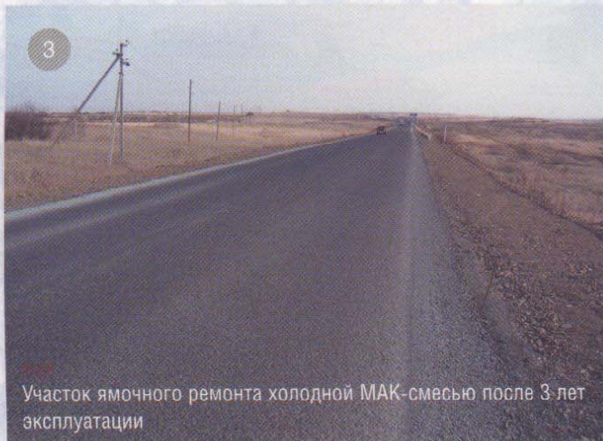
Ямочный ремонт заполнением выбоин холодной МАК-смесью
