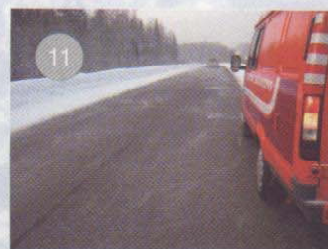
>>> Состояние покрытия (3-слойного с верхним слоем из МАК-ЩМА) в феврале 2008 года
