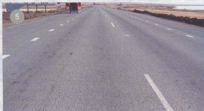
&gt;&gt;&gt; Участок с покрытием из холодной МАК-смеси после 3 лет эксплуатации
