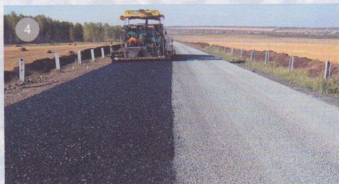
&gt;&gt;&gt; Верхний слой покрытия из холодной МАК-смеси
