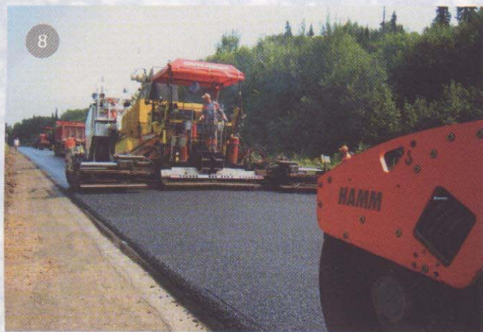
>>> Укладка верхнего слоя из МАК-ЩМА на всю ширину покрытия
