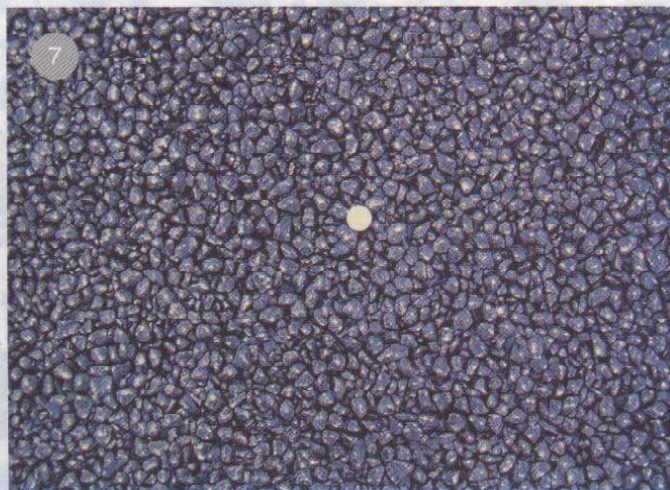
&gt;&gt;&gt; Вид уплотненного дренирующего слоя из МАК-смеси
