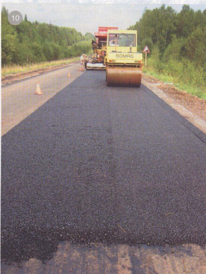
>>> Укладка верхнего слоя из холодной МАК-смеси на половину ширины покрытия
